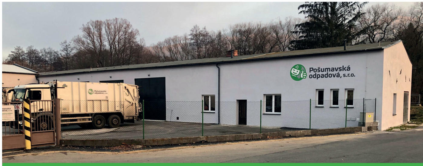
Nové zázemí sběrného dvora v Sušici. Foto: archiv společnosti Pošumavská odpadová
